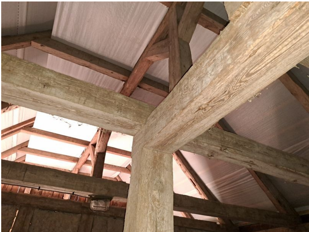
stodola – konstrukcja dachu
