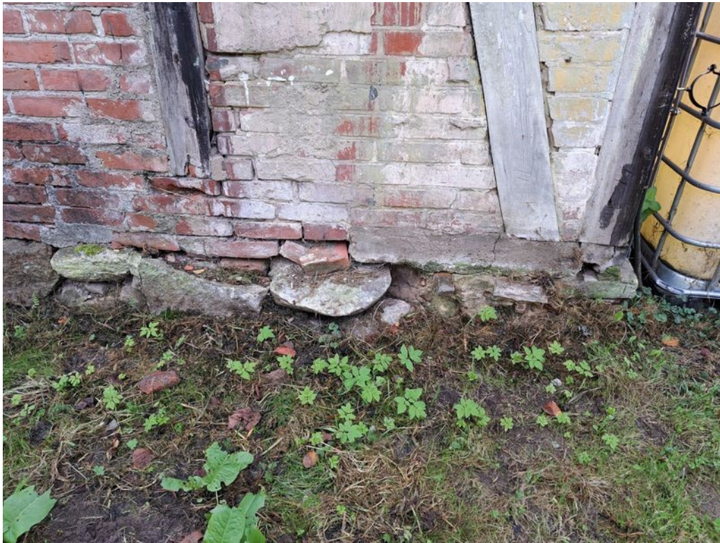
stodoła – ruchome kamienie w fundamentach
