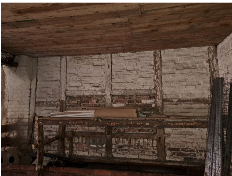
chlewik – konstrukcja ściany parteru – mur pruski
