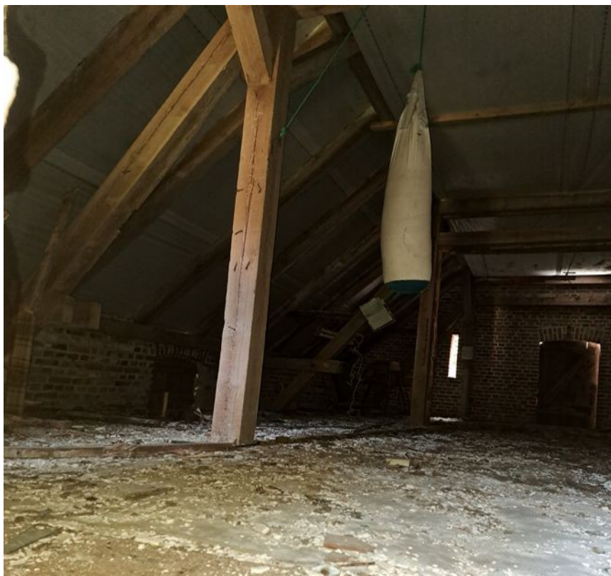
chlewik – konstrukcja drewniana poddasza
