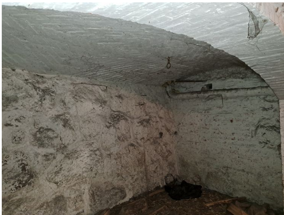
leśniczówka - sklepienia nad piwnicą i kamienne ściany piwnic
