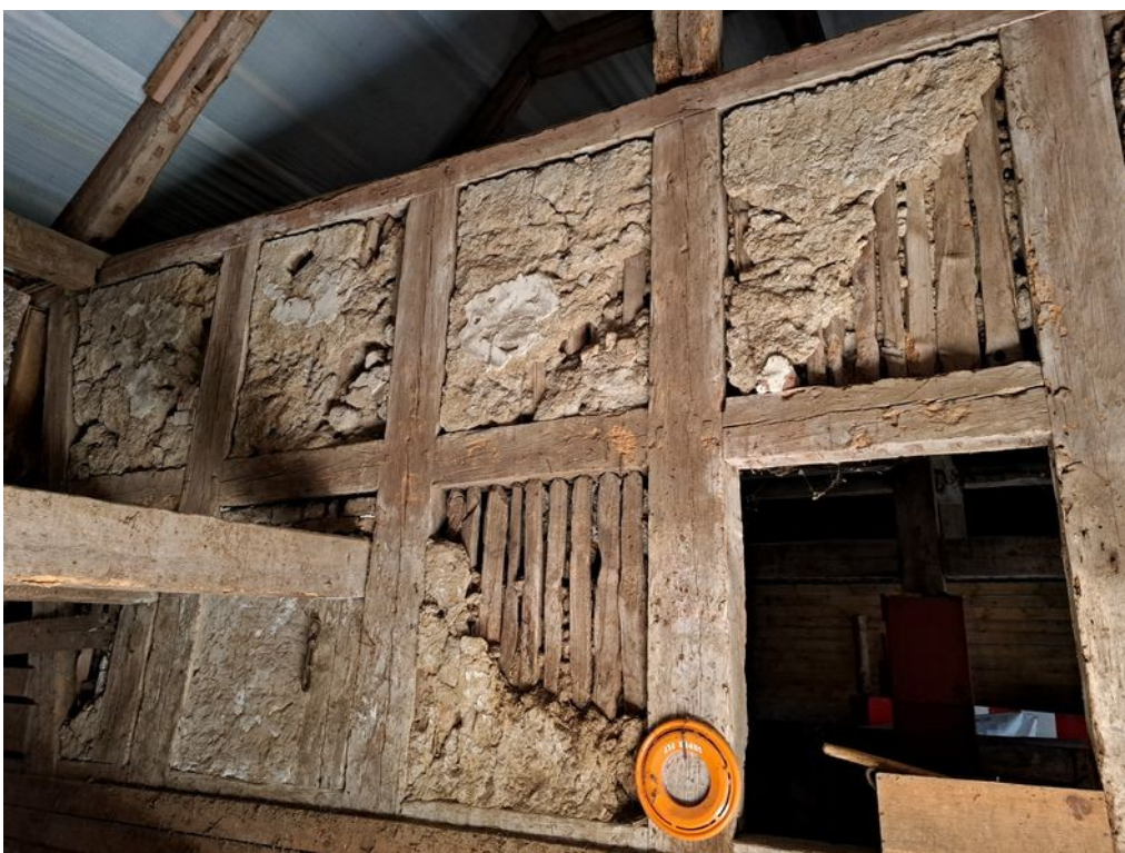
stodoła – wyeksploatowana wewnętrzna ściana szachulcowa
