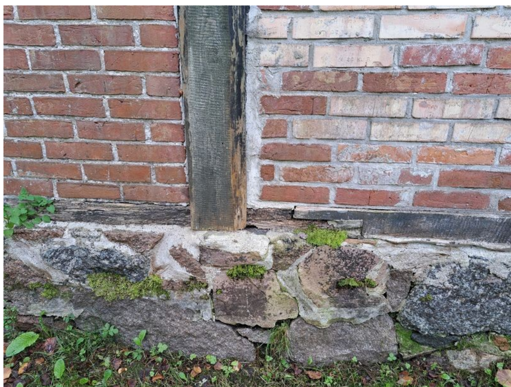
stodola – fundamenty kamienne
