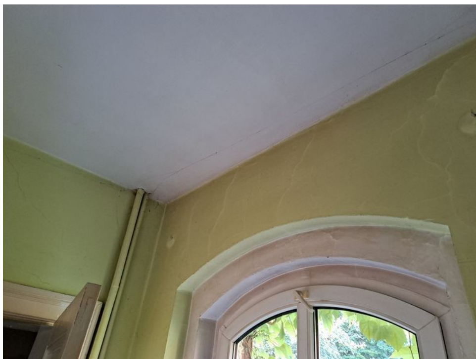
leśniczówka – drobne niegroźne pęknięcia tynku
